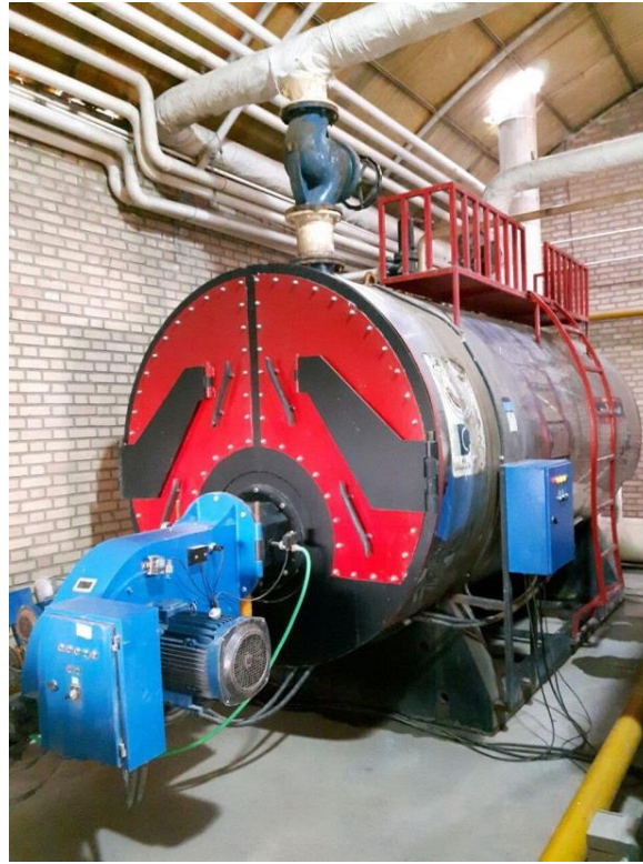
شکل (۲۵): شماتیک سیستم بویلر آب گرم
