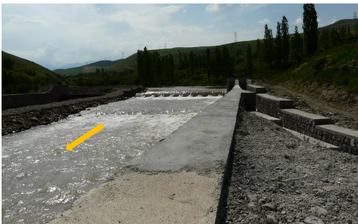
شکل ۲۳- نمای کلی بند دیدان در رودخانه باراندوزچای در زیربازه CD از بازه محل اتصال رودخانه درین قلعه به باراندوزچای - ایستگاه هیدرومتری دیزج
