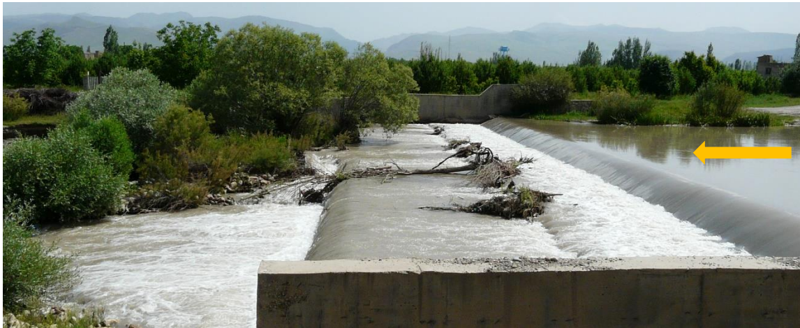
شکل ۱۸- فرسایش کفبند بند دیزج تکیه و رشد درختچه‌ها در پایین دست سرریز آن در رودخانه باراندوزچای در زیربازه AB از بازه محل اتصال رودخانه درین قلعه به باراندوزچای - ایستگاه هیدرومتری دیزج
