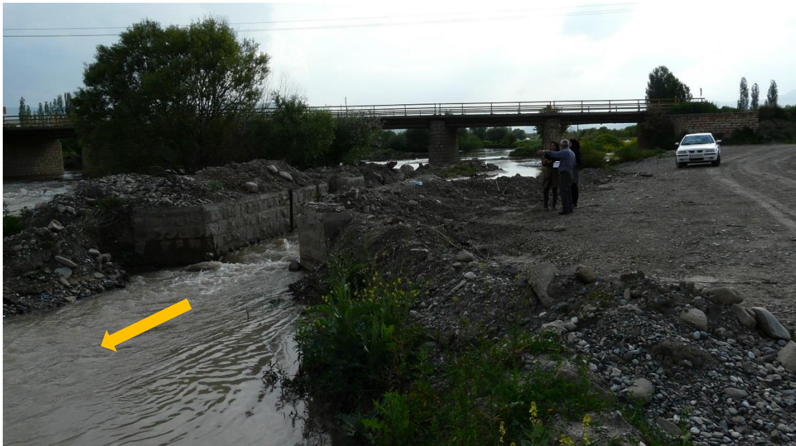
شکل ۱۹- نمای کلی پل بالانج و سردهنه نهر اردوشاهی در رودخانه باراندوزچای در زیربازه AB از بازه محل اتصال رودخانه درین قلعه به باراندوزچای - ایستگاه هیدرومتری دیزج
