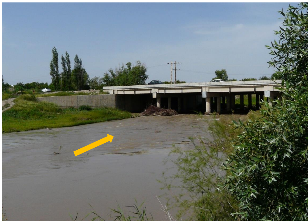
شکل ۱۱- تصویر پل واقع در جاده ارومیه - مهلباد
