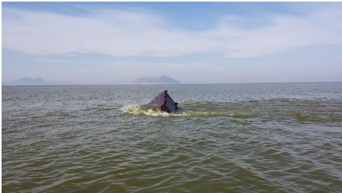
شکل ۲۰. آثار شدت جریان آب دریاچه در نزدیکی زیرگذر پل شهید کلانتری در برخورد با مانع قابل توجه است
