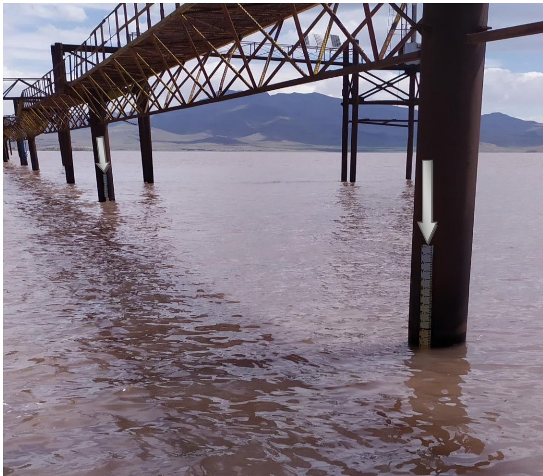
تصویر دو اشل معرفی‌شده از سوی کارفرما برای قرائت تراز سطح آب
