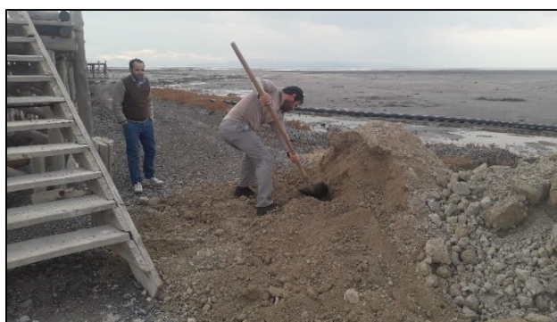
شکل 35) هموار سازی مسیر جهت ورود به حریم دریاچه
