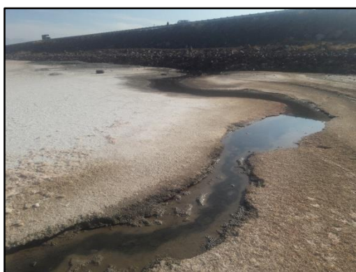
شکل 59) نفوذ آب شیرین از گل های بیرون زده (حاصل از فشار سازه) S21
