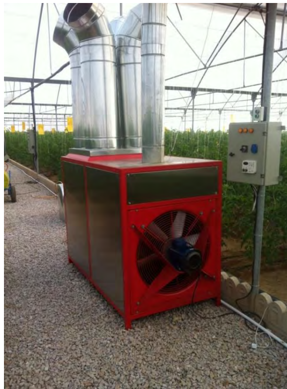
شکل (۲۴): شماتیک سیستم بخاری هوای گرم
