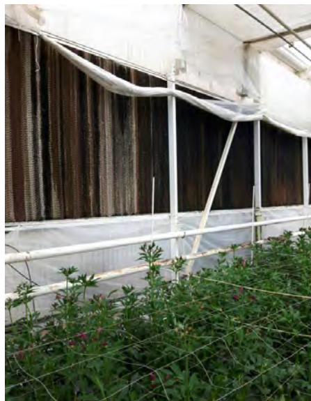
شکل(۴۷): نمایی از سیستم فن و پد مورد استفاده در گلخانه پاکدشت ورامین
