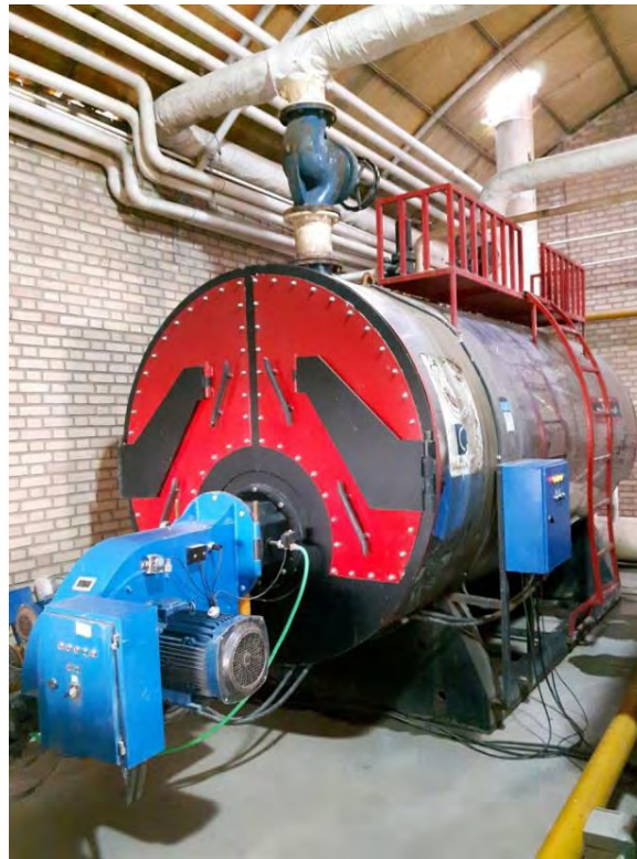
شکل (۲۵): شماتیک سیستم بویلر آب گرم
