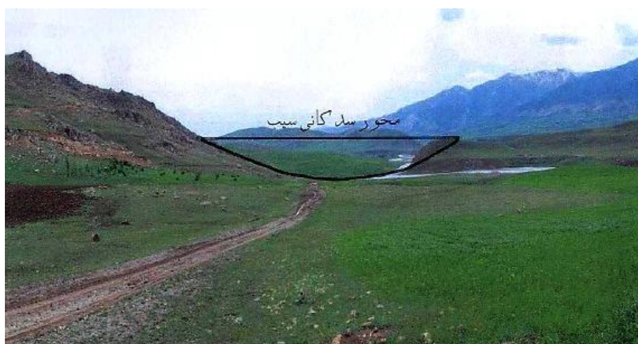
شکل ۲۰. محور ساخت سد کانی سیب [۱۶].
