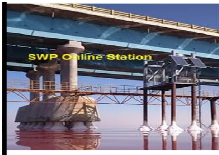
شکل ۳ - ایستگاه پایش آنالین دریاچه ارومیه
