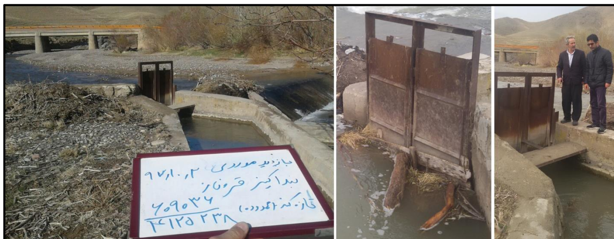
شکل ۳-۱۵- سردهنه قره‌ناز با وضعیت نامناسب، نیازمند تجهیز و باز در روز بازدید
