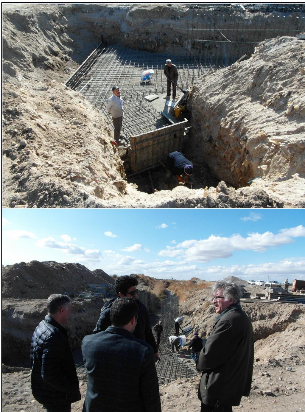
شکل ۳-۱۳- عملیات سردهنه‌سازی و نصب دریچه برای نهر آطارخی ( شهرستان تبریز، آبان ۹۷)
