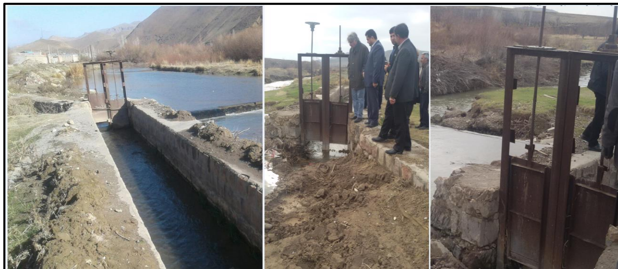
شکل ۳-۱۴- سردهنه انکیز با وضعیت نامناسب، نیازمند تجهیز و باز در روز بازدید
