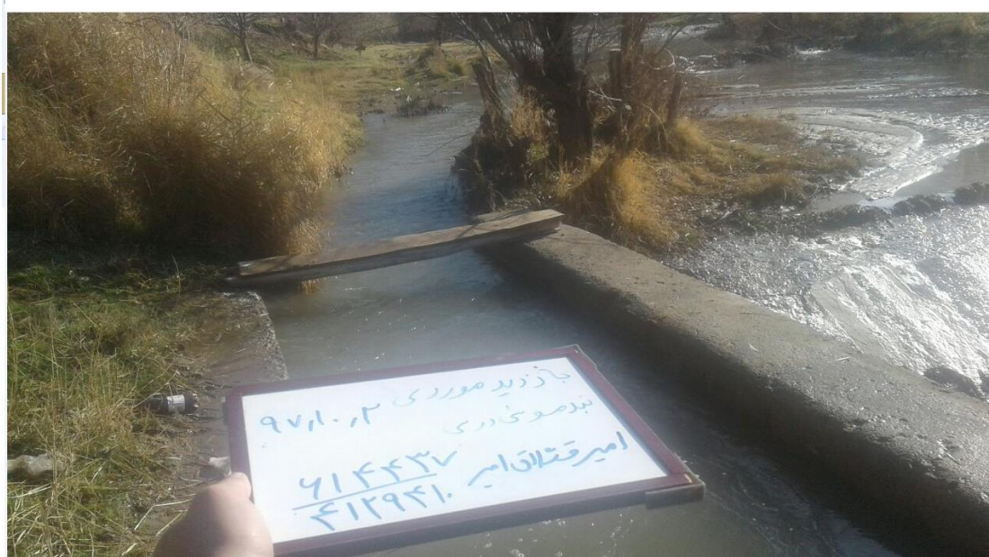
شکل ۳-۱۸- سردهنه قابان آرخی و موسی دره‌سی با وضعیت نامناسب، نیازمند تجهیز و باز در روز بازدید
