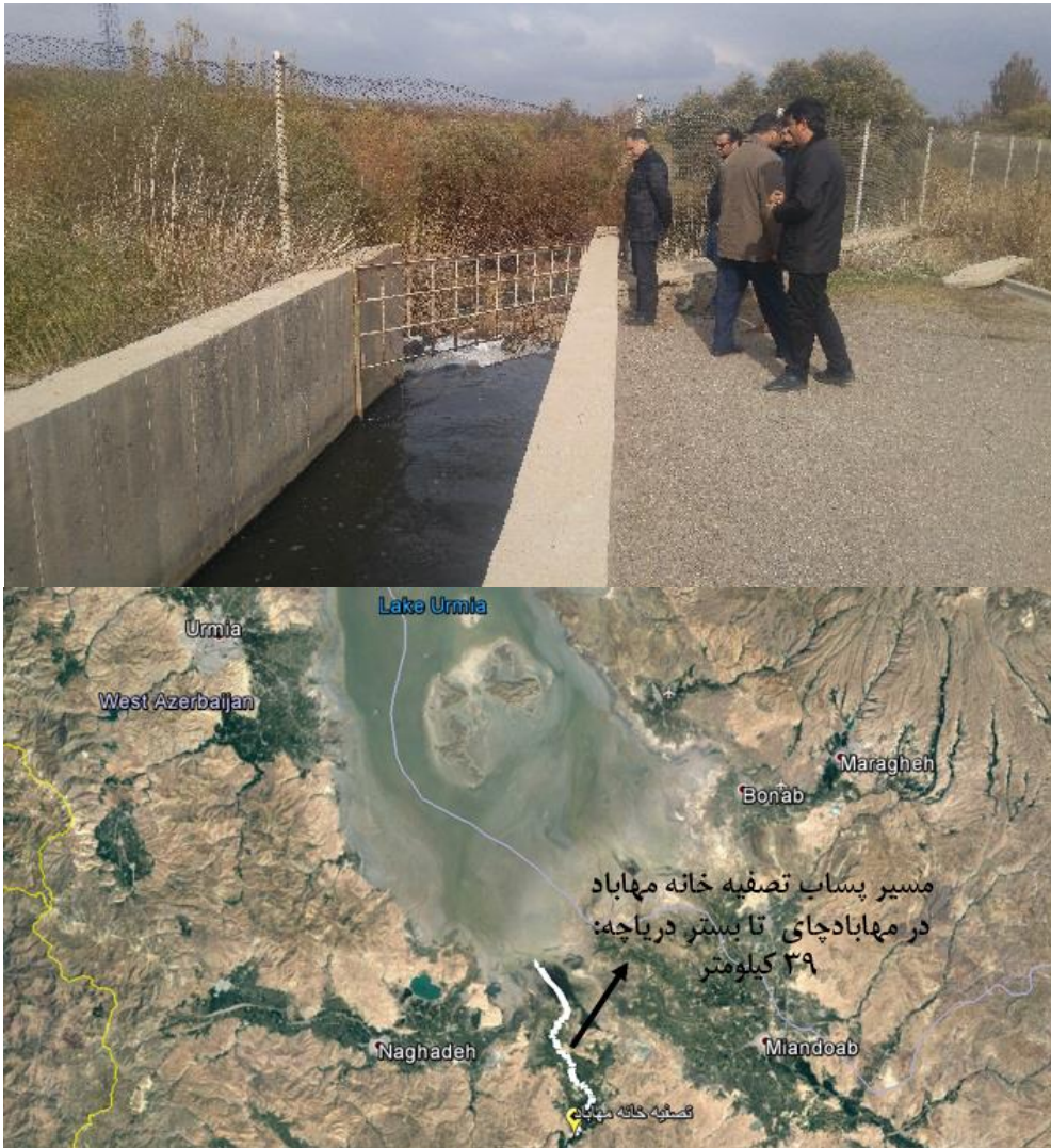
شکل ۱۱: محل خروج پساب از تصفیه‌خانه شهرستان مه‌آباد (شکل بالا) - مسیر پساب خارج شده از تصفیه‌خانه تا دریاچه ارومیه (شکل پایین): خروجی پساب از تصفیه‌خانه در مجاورت مه‌آبادچای - مسیر پساب در زرينه رود تا بستر دریاچه به طول ۳۹ کیلومتر
